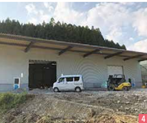
1 建設当初の1号倉庫 2 新設した事務所 3 相談者 4 融資が実行され完成した3号倉庫
